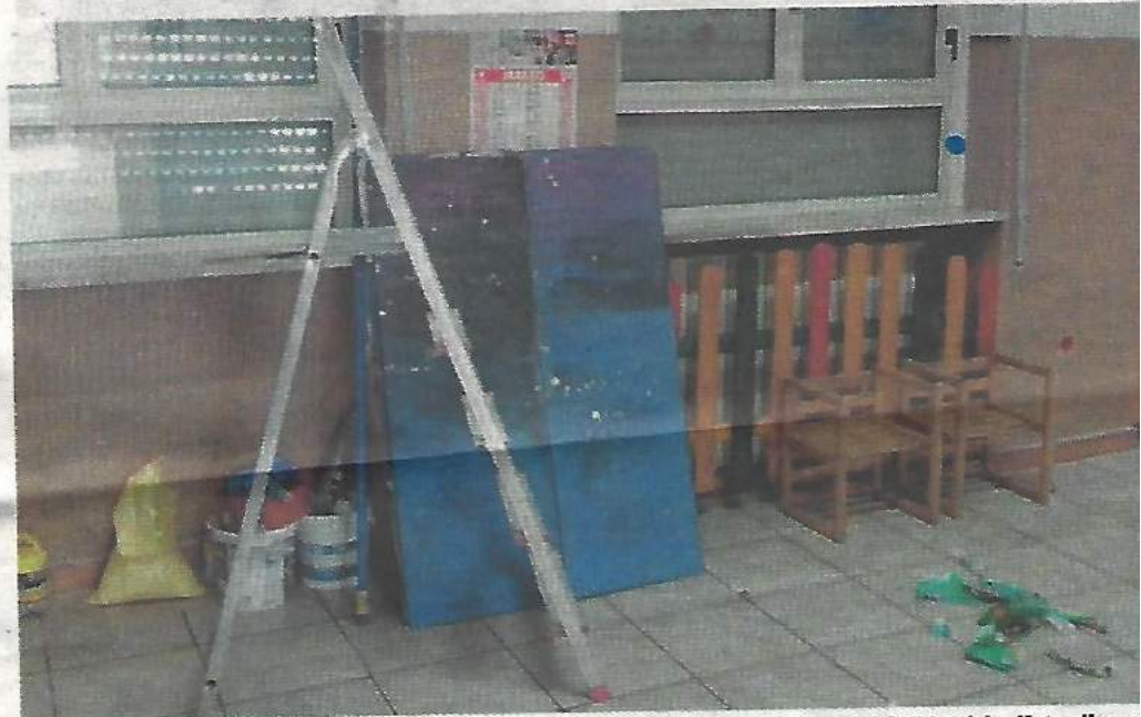
I bidoni di vernice e la scala nell'aula dove erano in corso i lavori nonostante le attività didattiche (foto ellesse
